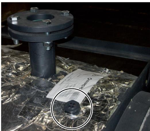
Вставить датчики и колбы термостатов в приёмные гильзы, которые находятся в верхней части теплообменника котла. Рекомендуется вставить датчики до дна гильз для обеспечения наилучшего контакта. Установить прижимную пружину и защёлки для удержания датчиков и колб.
